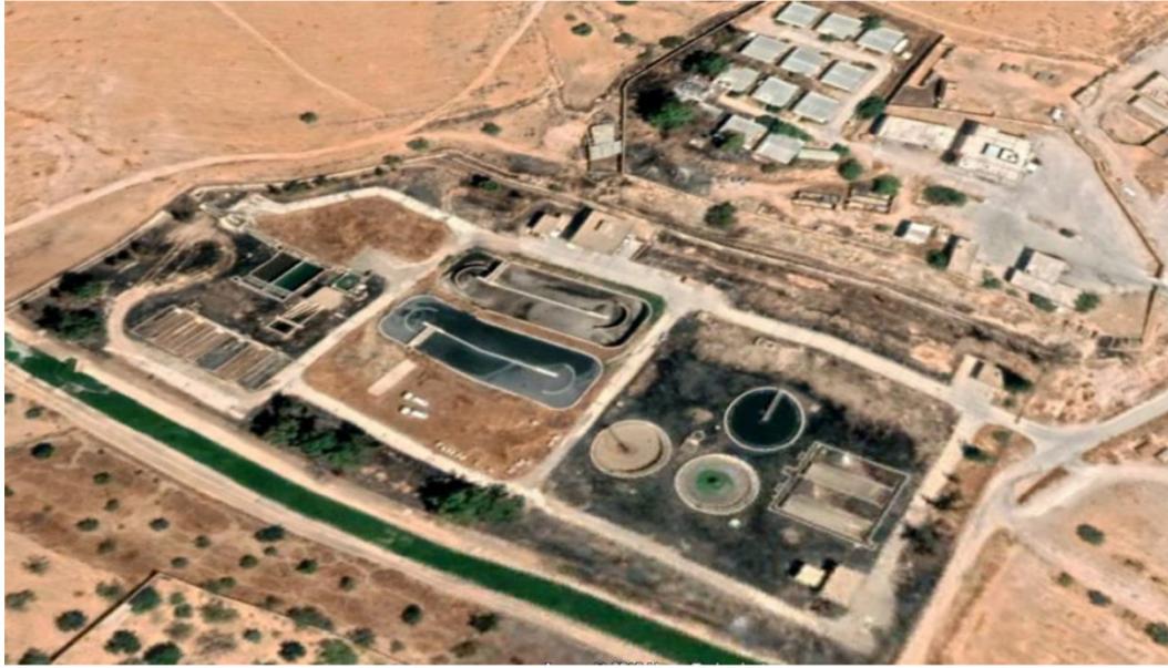
الشكل 3: صورة جوية لمحطة معالجة مياه الصرف الصحي بمدينة غريان [Source: https://earth.google.com/web/search/32.15153203,13.03476738,662.53720067a ]
